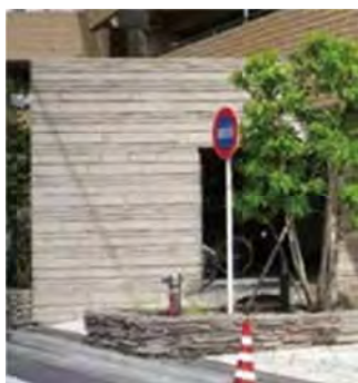
除去砂岩污垢，采用 TB-COAT 抗菌剂混合型经 6 年后效果图
